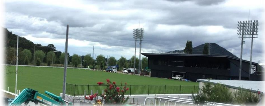
岩舟総合運動公園内に建設が進む「サッカースタジアム」
